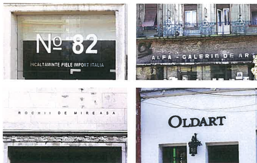
Exemple pozitive în signalistica Aradului contemporan Utilizarea vitrinei, fontul la dimensiuni umane și din materiale adecvate, litere volumetrice în armonie cu fațada, semnalizări discrete neinvazive.
